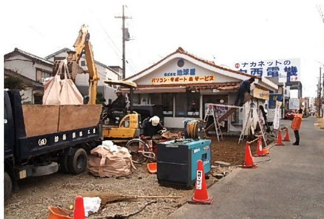
改修が始まりました
